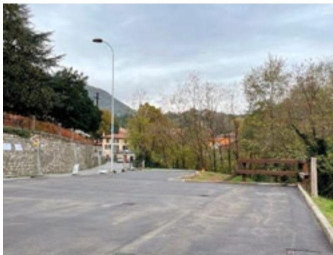
Ampliamento e asfaltatura del parcheggio di Via F.lli Manzoni
