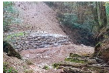
Via Ponte di Barlino (realizzati dalla CMVI)
