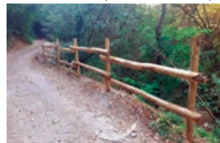
Via alla Vena (realizzati dalla CMVI)
