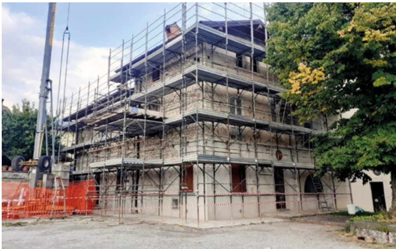
"Via" ai lavori di ristrutturazione della Villa dell'Amicizia
