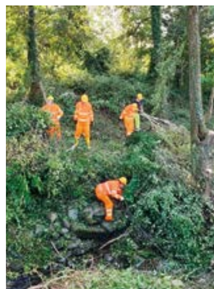
Interventi di pulizia dell'alveo del torrente Lesina da parte di operai e di volontari della Protezione Civile Bergamo Ovest
