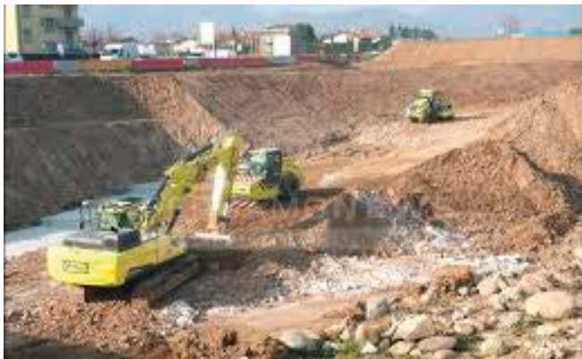
Una fase dei lavori di ampliamento della Treviolo-Paladina.
