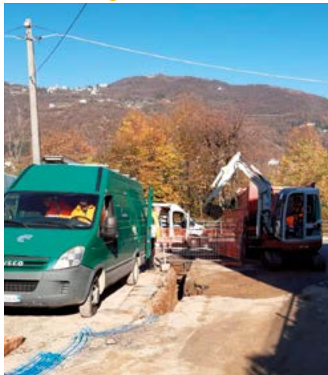
Rifacimento della rete acquedottistica di Via Canatore
