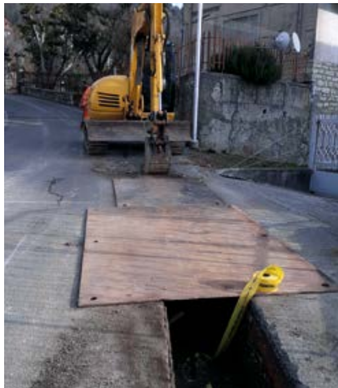
Sistemazione della fognatura nella contrada di Carosso
