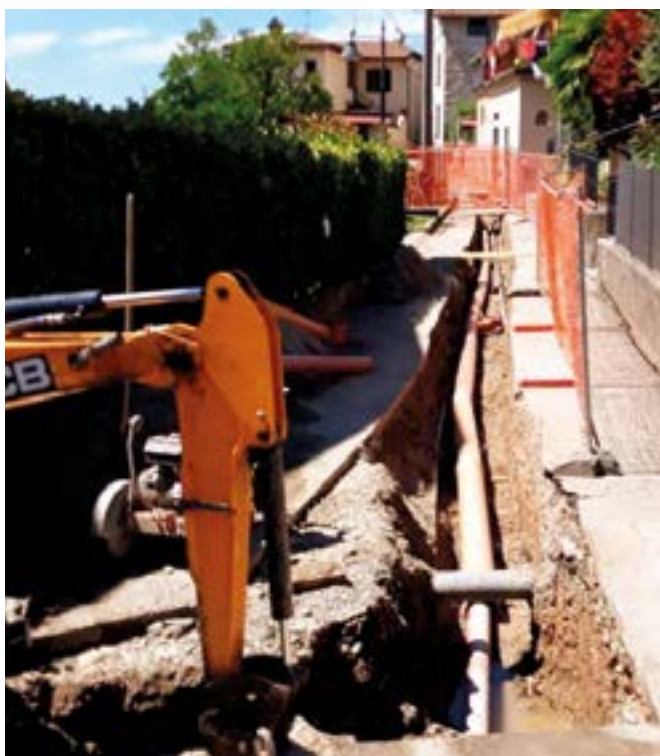
Sistemazione della fognatura di Via Cerita
