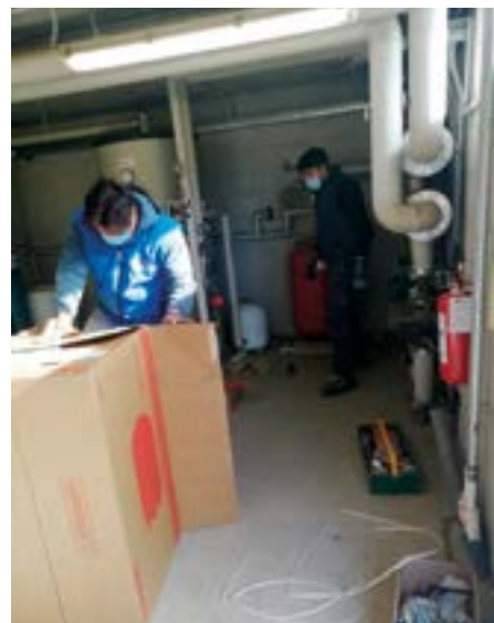
Intervento manutentivo alle caldaie del Palalemine
