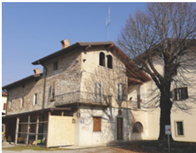
16 novembre 2021 - Ottenimento di un contributo regionale di quasi 1.000.000 di Euro a fondo perduto (Ristrutturazione della Villa dell'Amicizia)
