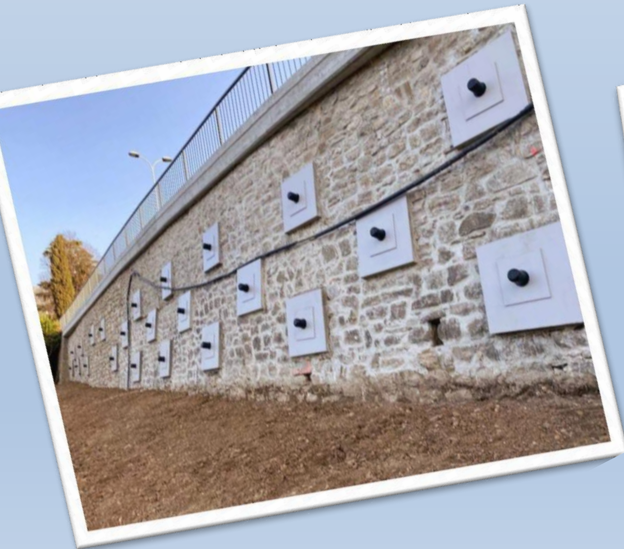
Muro via IV novembre
